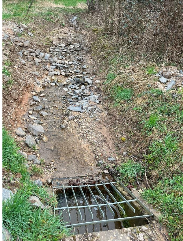
Abbildung 4.5: li. Einlaufbauwerk Straßenentwässerung Kreuzung „Auf der Ecke“/ K25; re. Einlaufbauwerk Bachlauf K25
