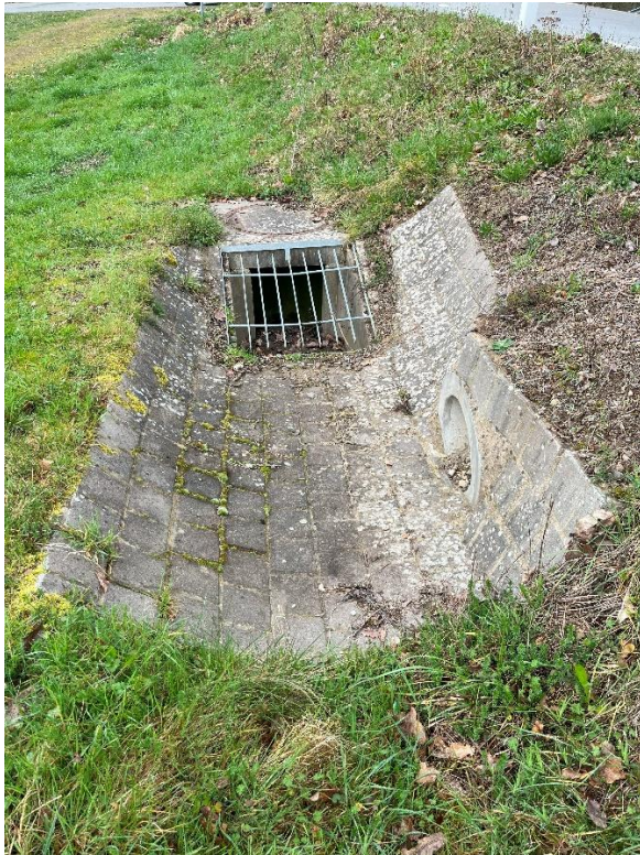
Abbildung 4.5: li. Einlaufbauwerk Straßenentwässerung Kreuzung „Auf der Ecke“/ K25; re. Einlaufbauwerk Bachlauf K25
