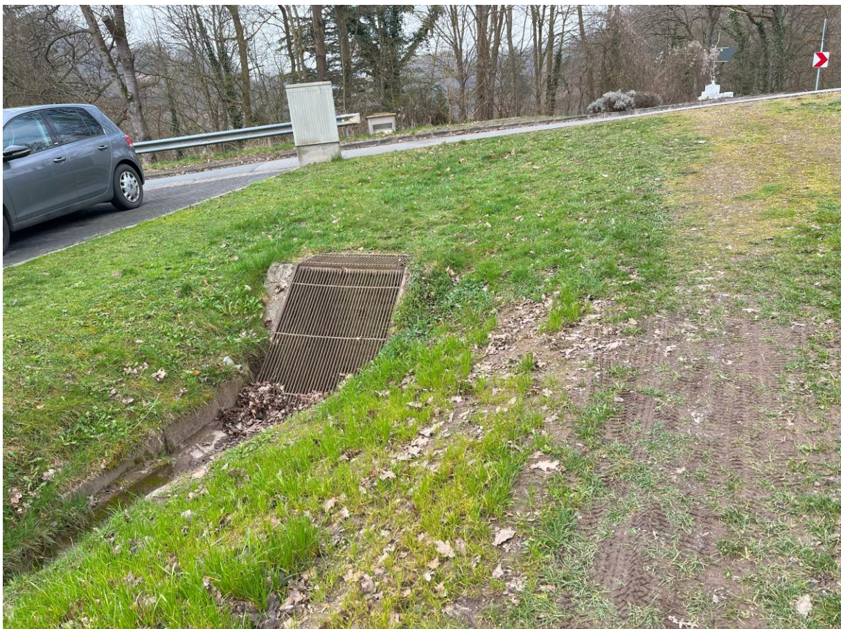
Abbildung 4.6: Einlaufbauwerk Graben Kreuzung „Auf der Ecke“/K25
