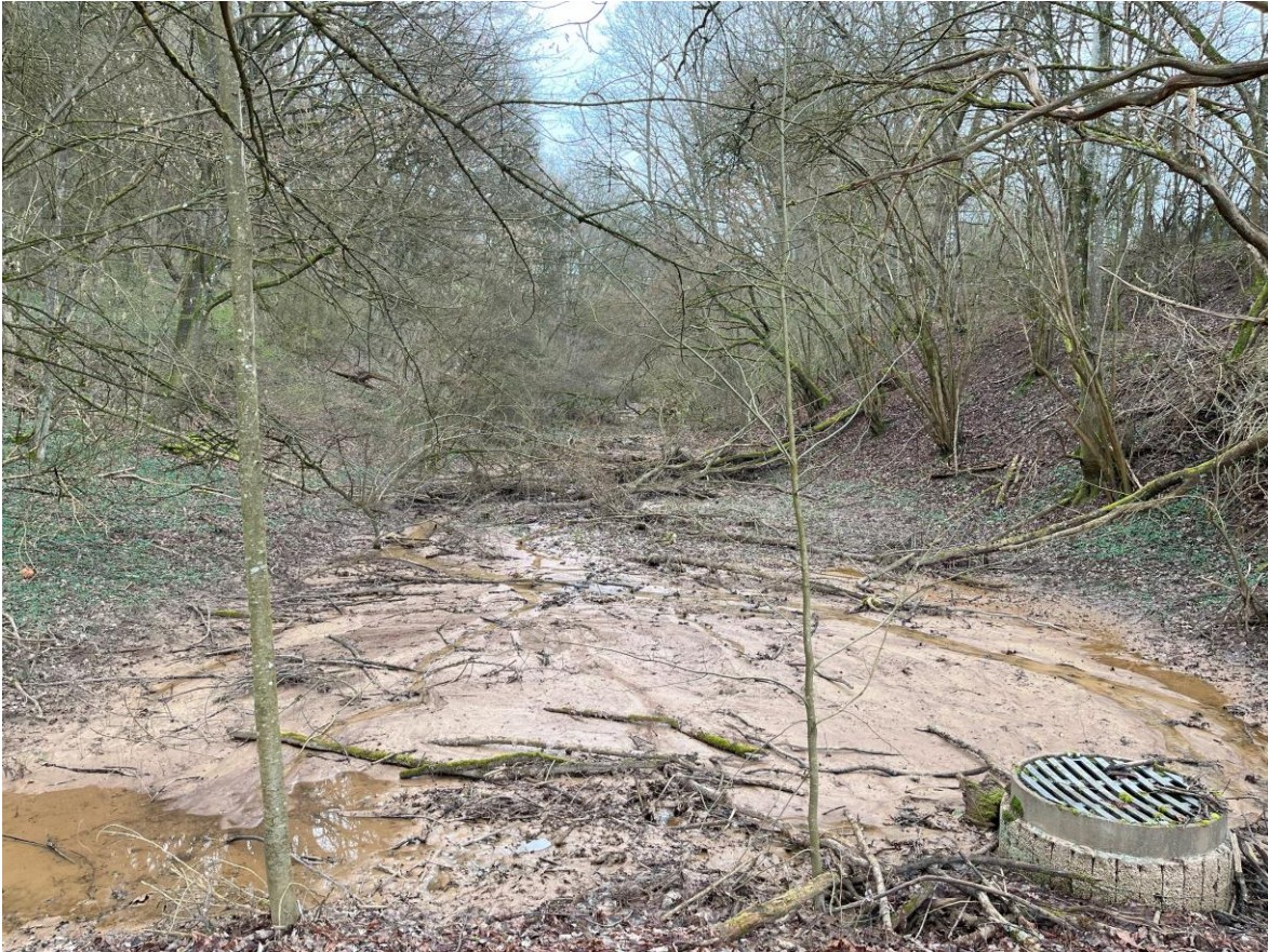
Abbildung 4.7: Retentionsfläche 1 „Am Stollen“ mit Ablaufschacht
